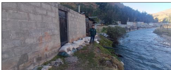
FIGURA N°03: Tramo del Río Huallaga pasando junto a una edificación, donde la margen presenta inestabilidad y erosión. Se observa sacos de arena o tierra apilados, indicando intentos de protección o mitigación.
