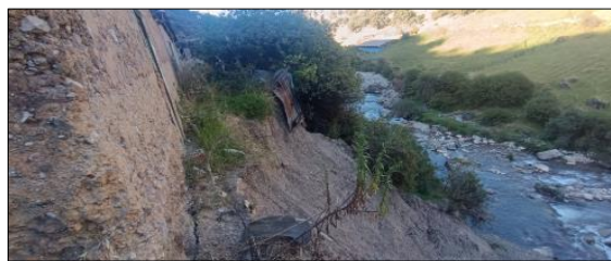
FIGURA N°02: Primer plano de una sección del Río Huallaga donde se observa una severa erosión de la margen derecha, con material de tierra y rocas desprendiéndose hacia el cauce, afectando directamente la estabilidad del terreno adyacente.
